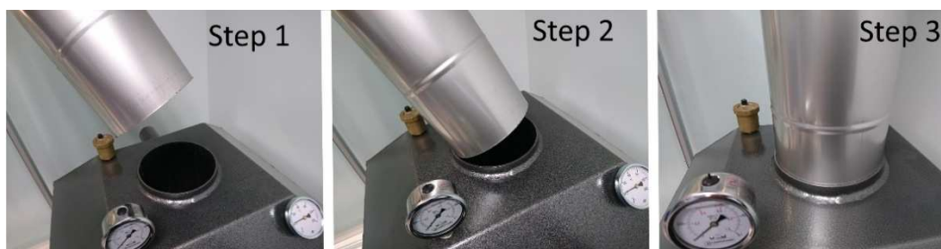
Image 4. Installation de cheminée
